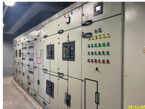
ระบบไฟฟ้าหลัก (MDB)
